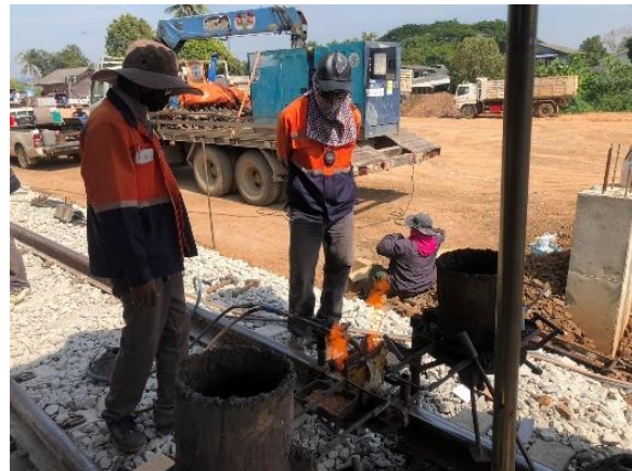
รูปที่ 1-182 งานเชื่อม thermite welding ในทางประธานเดิม กม.101+173
