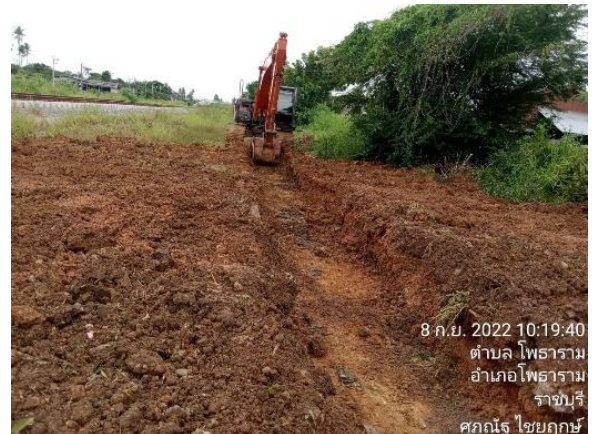
รูปที่ 1-71 งานขุดร่องน้ำไหลคั่นทาง กม. 82+300-82+500
