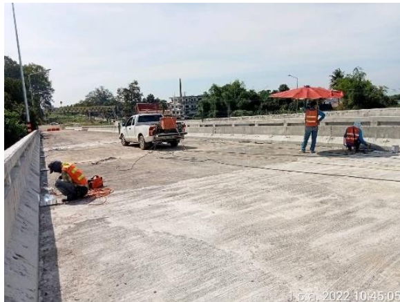
รูปที่ 1-169 งานใส่ฝาทะแหรง gully U-Turn กม. 79
