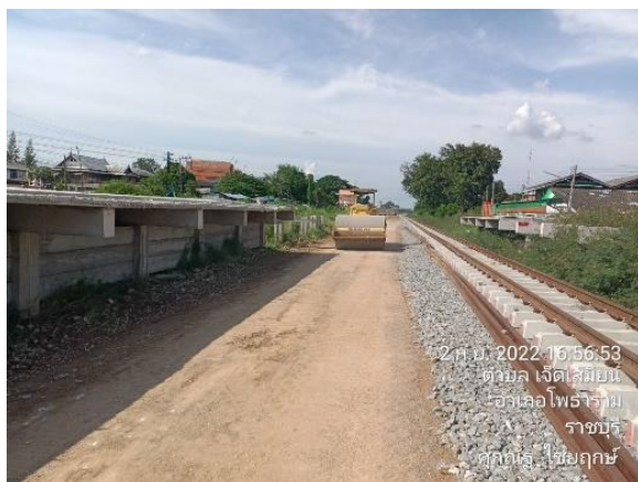
รูปที่ 1-66 งาน Shave-ปรับพื้นที่+compaction.Hand-Overสถานีเจ็ดเสมียน
