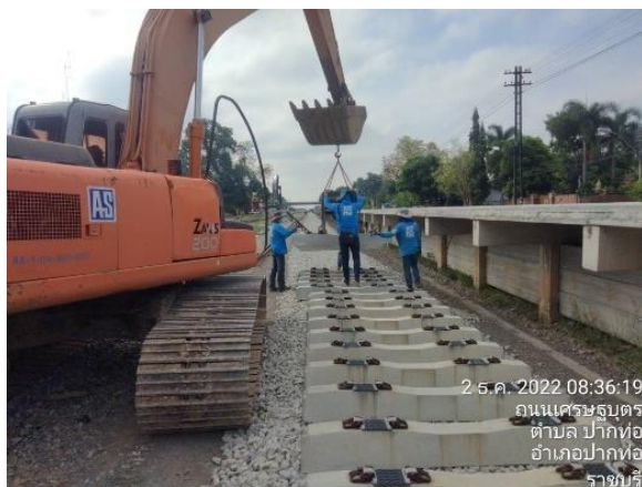
รูปที่ 1-171 งานวางหมอนคอนกรีต ย่านสถานีปากท่อ
