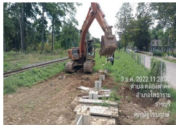
รูปที่ 1-172 งานปรับดินเสริมดินกำแพงกันเสียง ไหล่ทาง กม. 79/5-79/7
