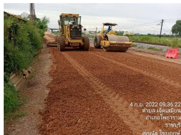
รูปที่ 1-69 งาน Mix-Process+Compaction. Base-Course กม.90+500-90+625
