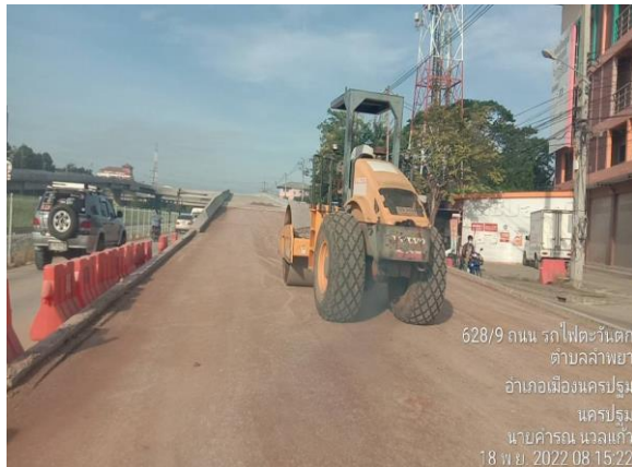
รูปที่ 1-140 งานบดอัดทางขึ้น-ลงสะพานU-Turn (U-Turn Road) Km. 50+600 RT
