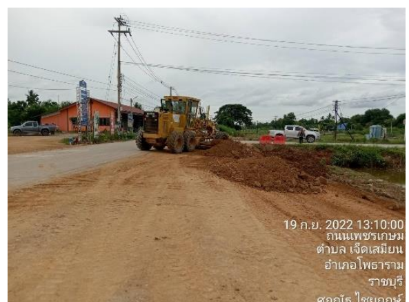
รูปที่ 1-75 งานขยายไหล่คั่นทาง-เสริมวัสดุดิน+ลูกรัง+ compaction U-turn กม.90+450-90+550
