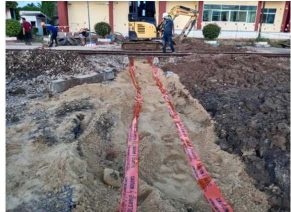
รูปที่ 1-219 งานก่อสร้าง Main Cable PIT and Under Track
