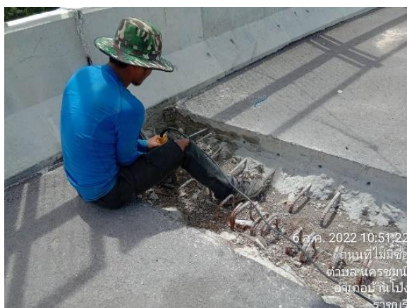
รูปที่ 1-45 งานเจาะเสียบเหล็กเสริมพิเศษ ExpansionJoint กม. 71+779
