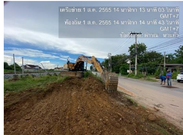
รูปที่ 1-36 งาน Clearing U-Turn Road เพื่อติดตั้งเต้าไฟ กม. 69+500
