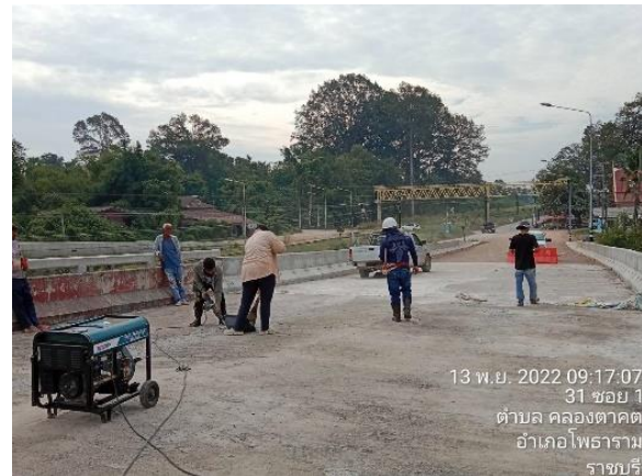
รูปที่ 1-135 งานสกัดบดแต่งข้างๆ concrete barrier กม. 69+387
