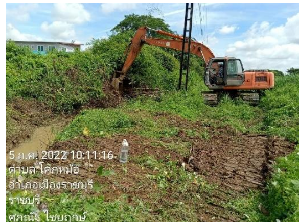
รูปที่ 1-7 งานขุดร่องน้ำไหลคั่นทาง กม 69+312-96+187
