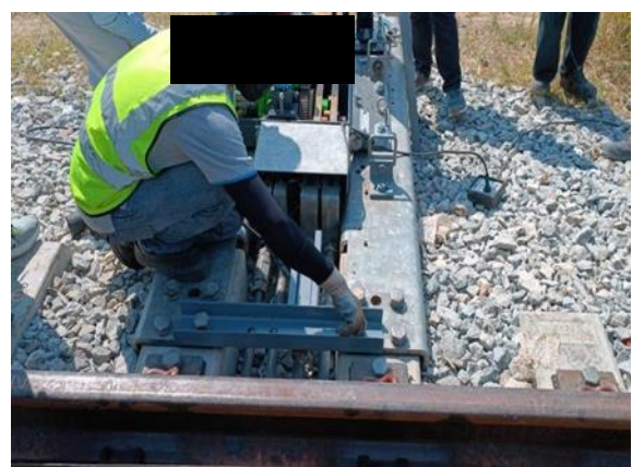
รูปที่ 1-222 ดำเนินการจัดทำ Mockup ติดตั้งอุปกรณ์ Point Machine
