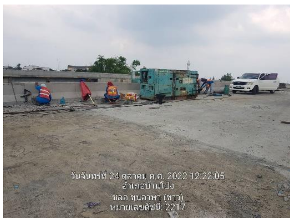
รูปที่ 1-101 งานเจาะรูใส่ gully สะพาน U-Turn กม. 67
