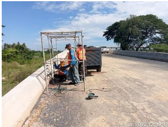
รูปที่ 1-175 งานเจาะ Barrier กม. 63
