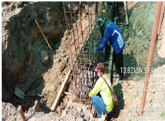
รูปที่ 1-177 งานเข้าแบบ+ผูกเหล็กสะพาน กม.58+545
