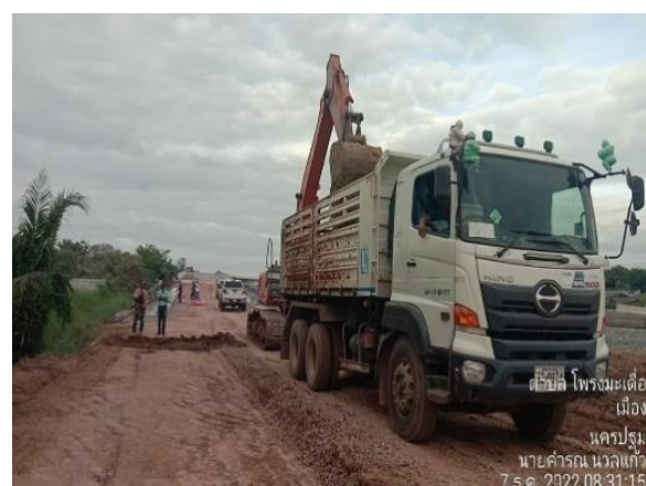
รูปที่ 1-174 งานแก้Soft+ งานMix ปูบดอัดทางขึ้น-ลง สะพานU-Turn กม. 54+400
