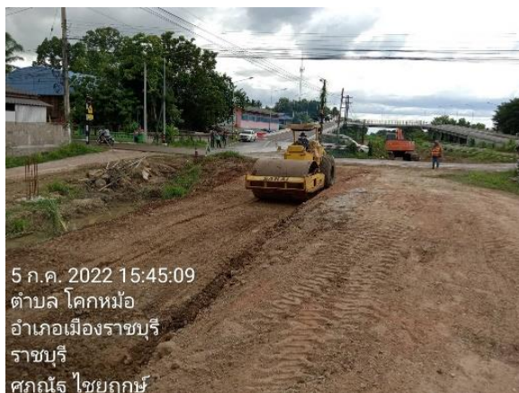
รูปที่ 1-8 งานขุด-cut+เสริมดินพื้นที่กำแพงกันเสียงไหล่ คันทาง กม 96+650-96+750
