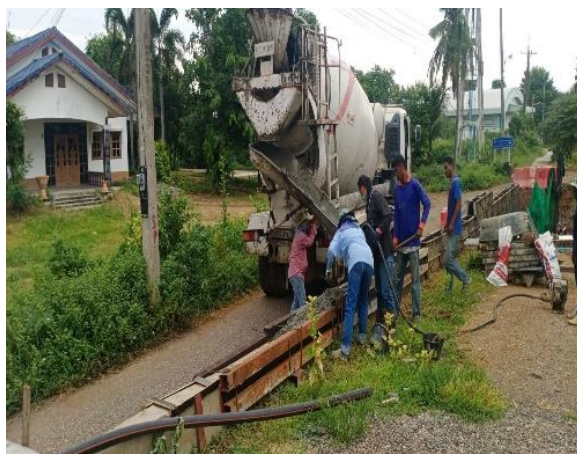
รูปที่ 1-37 งานเทคอนกรีตกำแพงกันดิน กม. 63
