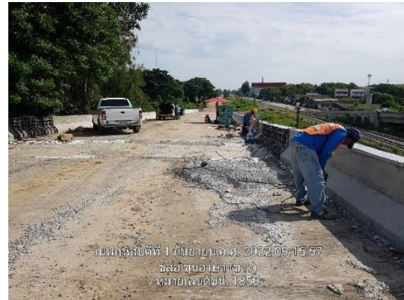
รูปที่ 1-65 งานเจาะรูใส่ gully U-turn กม. 69
