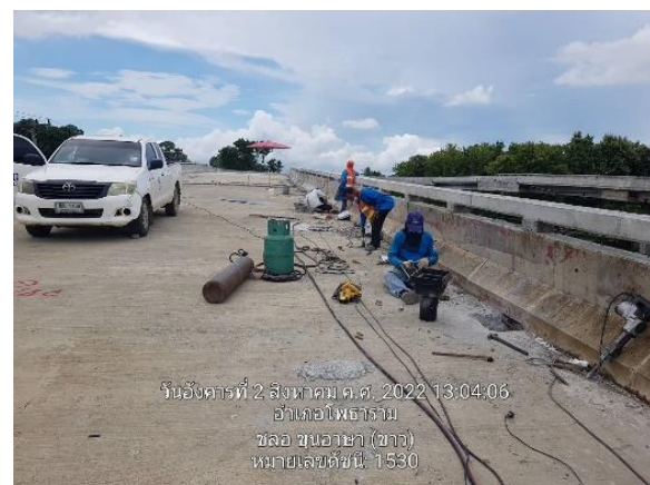
รูปที่ 1-38 เจาะรูใส่ gully T-urn กม. 79
