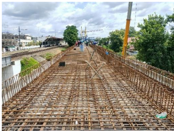
รูปที่ 1-6 งานเทพื้นคอนกรีตสะพานเชิงลาดแม่กลอง
