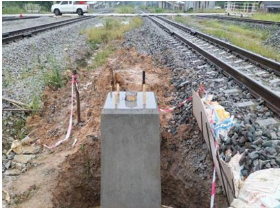
รูปที่ 1-218 งานก่อสร้างฐาน Signal
