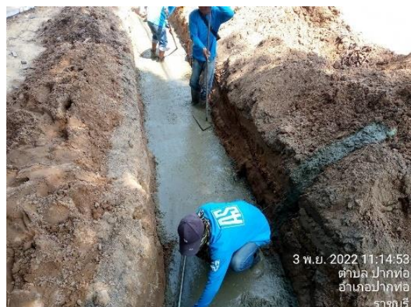
รูปที่ 1-127 เทลื่นรองท่อและรางยู สถานีปากท่อ
