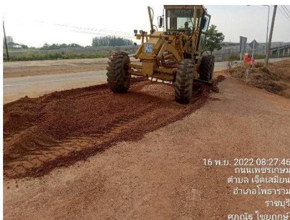
รูปที่ 1-138 งานปรับเสริม+compactionหินคลุกขยาย ไหล่คันทาง U-Turn กม.90+600
