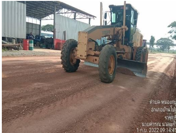
รูปที่ 1-64 งานปรับปรุงSubballast (Overpass Road) กม 63+857
