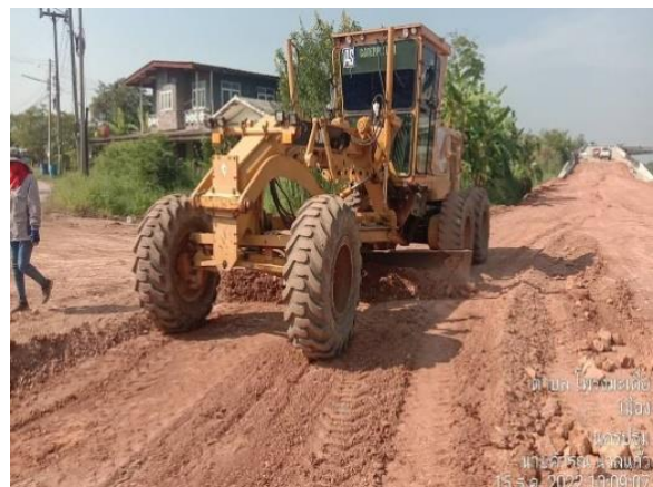
รูปที่ 1-180 งานตัดเกรดSubbaseทางขึ้น-ลง สะพานU-Turn กม. 54+400
