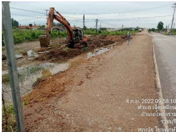
รูปที่ 1-70 งานขุดร่องน้ำระบายน้ำไหลคั่นทาง กม. 90+000-90+525
