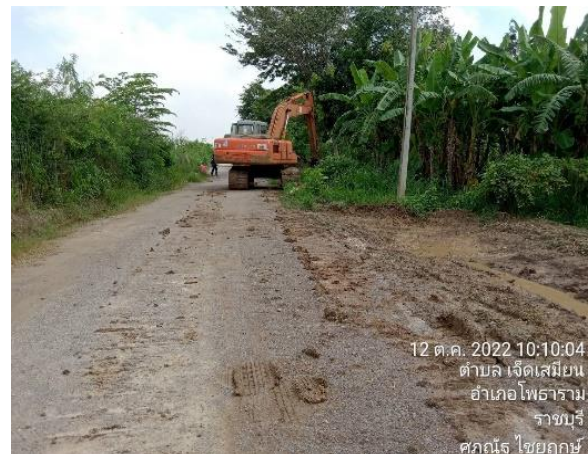
รูปที่ 1-100 งานclearing ขยายไหล่คันทาง box กม.90+210
