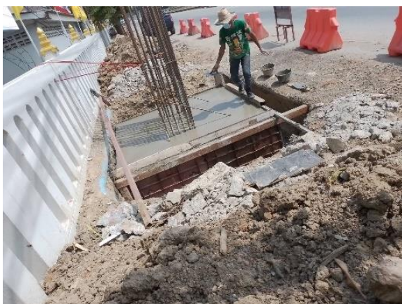
รูปที่ 1-126 งานเทคอนกรีตสะพานลอย กม. 49+575
