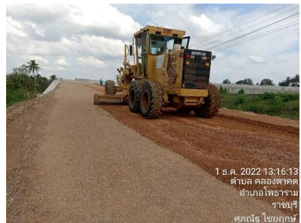
รูปที่ 1-164 งาน Mix.Process.Base-Course สะพาน U-Turn กม.76+042
