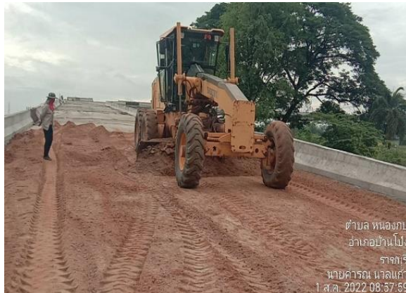
รูปที่ 1-35 งาน Mix-ปูบดอัดSubballast (Overpass Road) กม. 63+857
