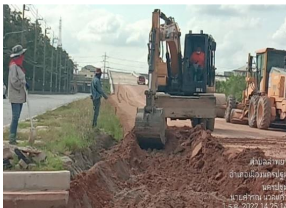
รูปที่ 1-167 งานลงSubballast แก่ Soft ทางขึ้น-ลงU-Turn กม. 50+600
