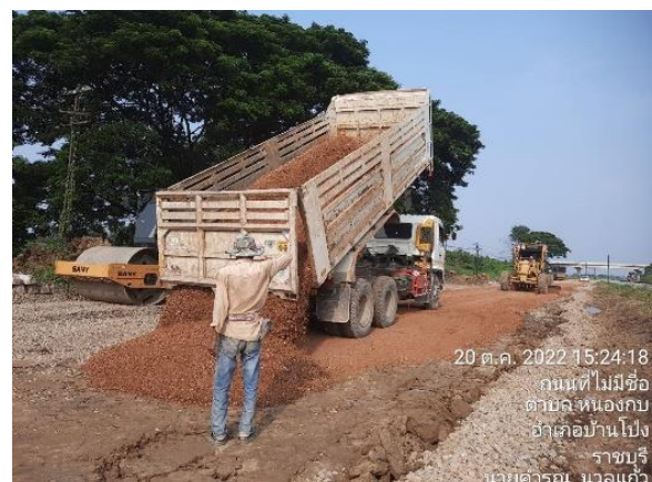
รูปที่ 1-102 งานแก้Soft+ ลงSubballast + ปรับปรุงอัดงานคันทางกม. 61+500-61+680
