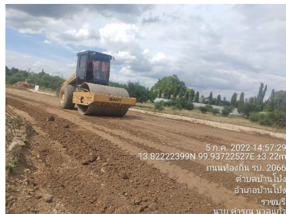
รูปที่ 1-9 งานลงดิน+ปรับ+บดอัด Overpass กม 61+200
