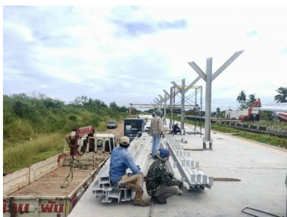
รูปที่ 1-74 งานติดตั้งหลังคาขานขาลา ฝั่ง Siding ย่านสถานีบางเค็ม
