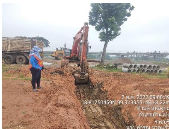
รูปที่ 1-39 ขุดวางท่อ งาน U-Turn Road กม. 63+800
