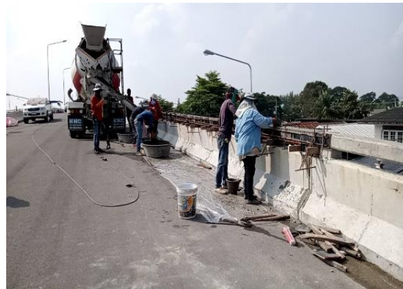
รูปที่ 1-123 งาน เทคอนกรีตราวสะพาน Overpass กม. 51+304
