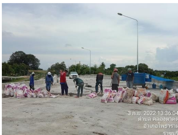
รูปที่ 1-68 งานสกัดแต่งร่อง ExpansionJoint U-TURNกม.79+006
