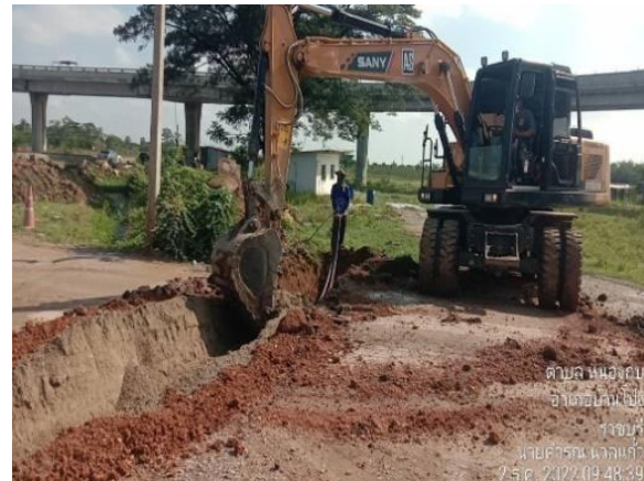
รูปที่ 1-170 งานขุดวางท่อสายไฟ กม. 63
