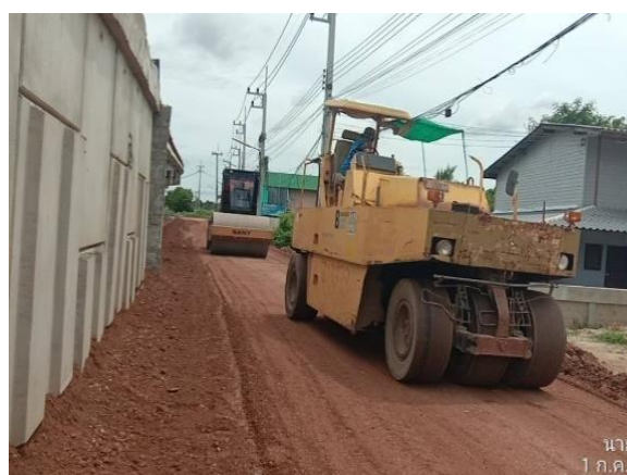
รูปที่ 1-3 งานลง subballast+Mix ปูบอัด Access Road กม 61+300
