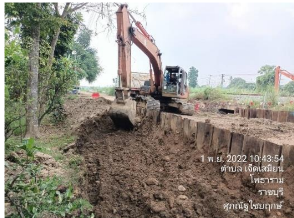
รูปที่ 1-125 งานขุด cut ถนนขยายไหล่คันทาง box กม .90+210
