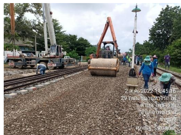
รูปที่ 1-40 งาน cutหินBallastเก่าปรับเสริมหินคลุก+ compactionวางหัวปะแฉ สถานีโพธาราม
