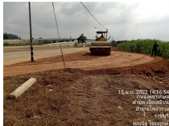
รูปที่ 1-137 งานเสริมหินคลุกขยายไหล่คันทาง+ compaction U-Turn กม.90+600
