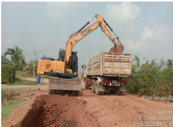
รูปที่ 1-124 งานแก้ไข soft+งานลง Subballast ปรับปรุง อัด (Access Road) กม. 53+800-54+800
