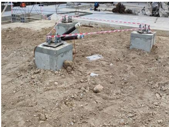
รูปที่ 1-220 งานก่อสร้างฐาน Concrete foundation of Radio Tower
