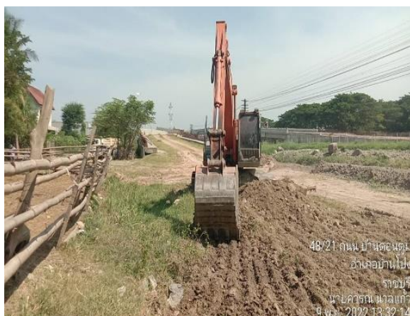
รูปที่ 1-132 งาน Clearing ทางขึ้น-ลงสะพาน U-Turn กม. 67+600
