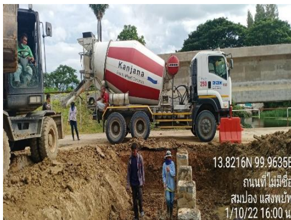
รูปที่ 1-93 งานเทลิ้นคอนกรีตสะพานรถยนต์ กม. 58+545
