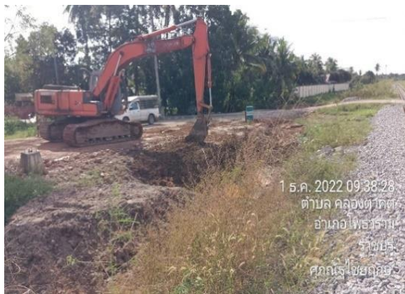
รูปที่ 1-163 งาน Clearingพื้นที่ที่ไหล่คัน ทางสะพาน U-Turn กม. 90
