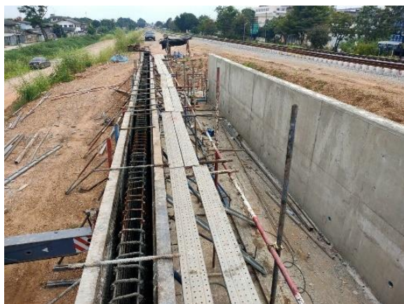
รูปที่ 1-130 งานเทคอนกรีตผนัง Transition สะพานเชิงลาดแม่กลอง
