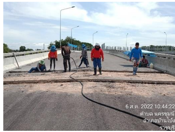
รูปที่ 1-44 งานสกัด+แต่งร่อง.ExpansionJoint. สะพานU-TURNกม. 71+779
