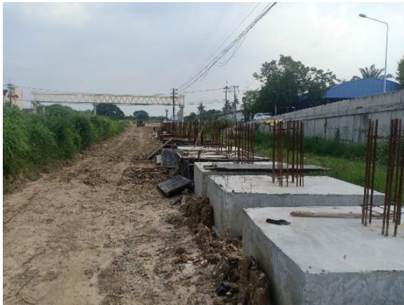
รูปที่ 1-122 เท footing Noise Barrier กม. 79+245
