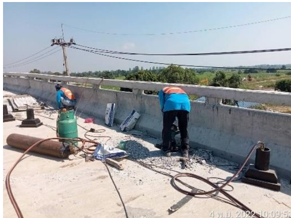
รูปที่ 1-128 งานเจาะใส่ gully สพาน Overpass กม. 61
