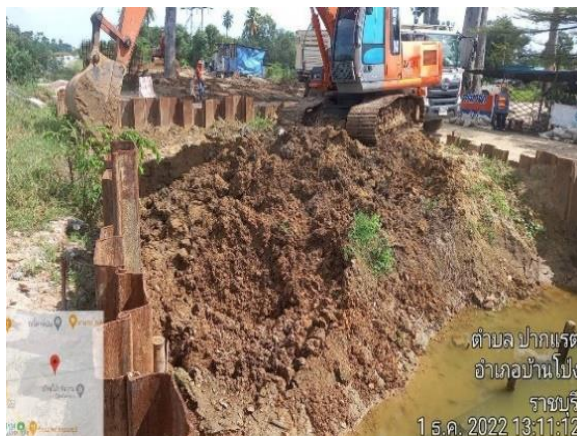
รูปที่ 1-165 งานขุดเปิดทางลง Box Culvertกม. 65+700
