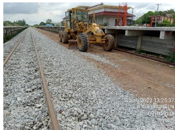
รูปที่ 1-94 งานShaveปรับหินคลุกคันทาง+ compaction ย่านสถานีเจ็ดเสมียน
